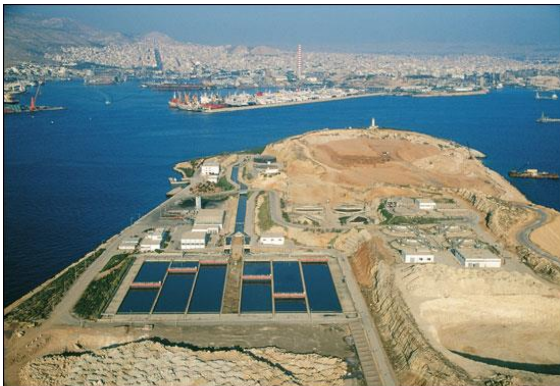
Σχήμα 4.4. Κέντρο Επεξεργασίας Λυμάτων Ψυττάλειας
