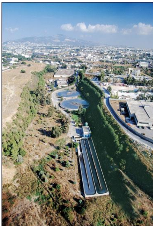
Σχήμα 4.3. Κέντρο Επεξεργασίας Λυμάτων Μεταμόρφωσης (PFR)
